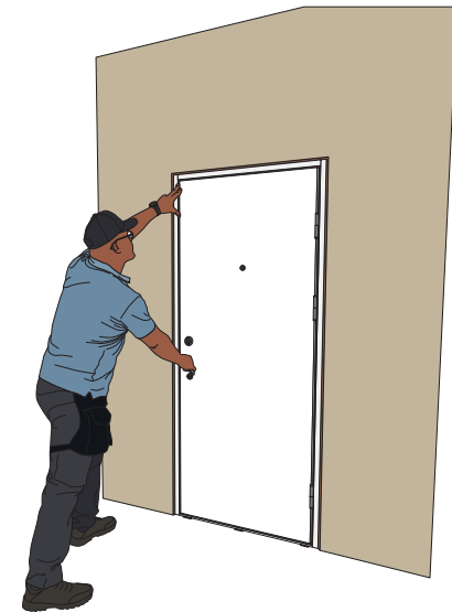
12 ŽINGSNIS. Patikrinkite uždarymo funkciją ir tarpines.
